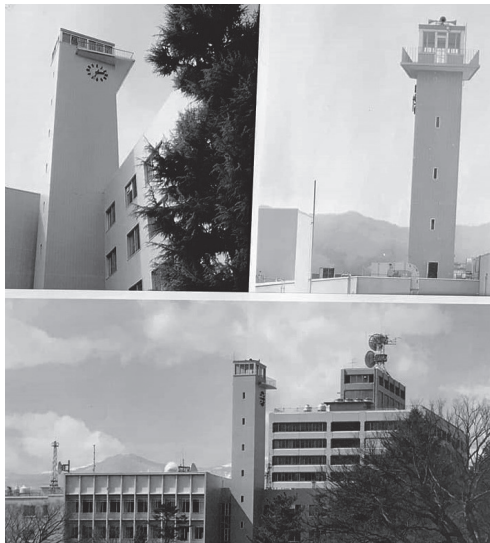
福島県本庁舎時計塔 提供=福島県施設管理課
