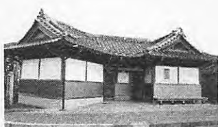
唐桑半島のトイレ 唐桑の公衆トイレはどこも立派 入ると音楽が流れ出すところもポイント
